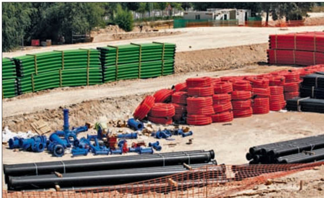
Estado de las obras de Nueva Arganda P. PRADERA / GENTE
